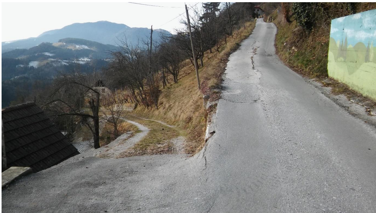
Slika 7: Pogled na plaz
